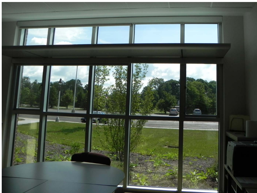
Light Shelves otimizando a iluminação em um escritório. Foto por Audobom - CC BY 2.0
